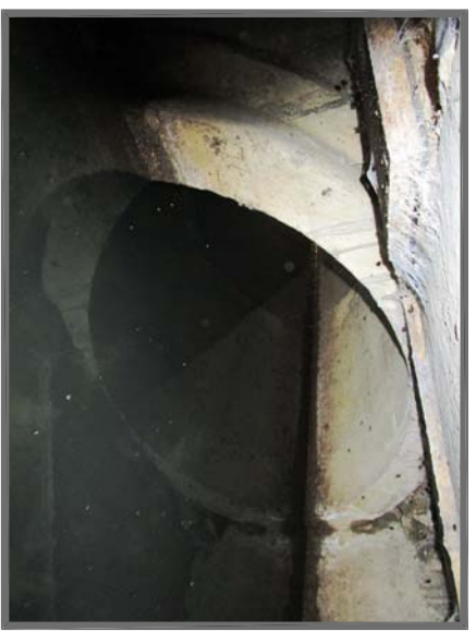
Schacht D 106.63: Abzweig B DN 1200
